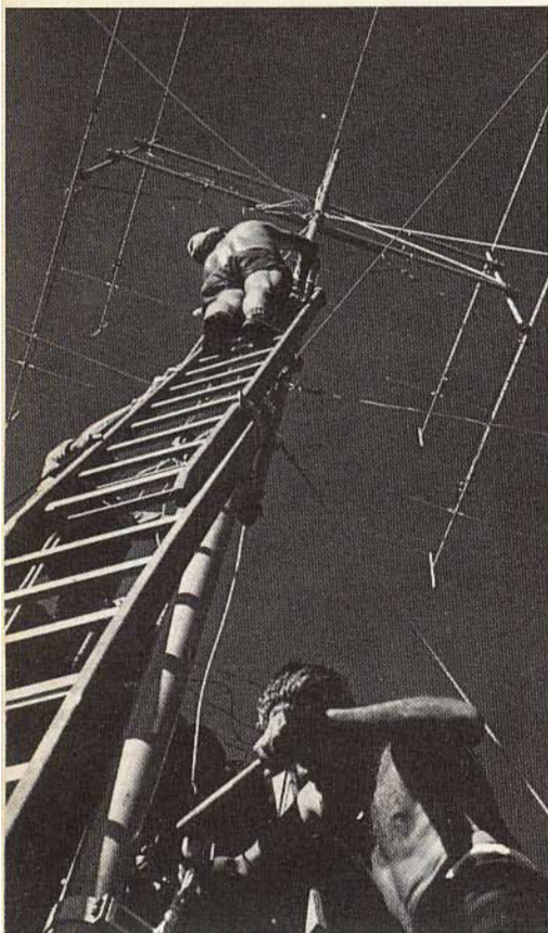
Fig. 3-4 - Fasi di montaggio dell'antenna HB9SV particolarmente delicate in cui necessitano stabilità d'appoggio base, controventatura a mezzo tiranti a scivolamento e molta fatica di braccia.
